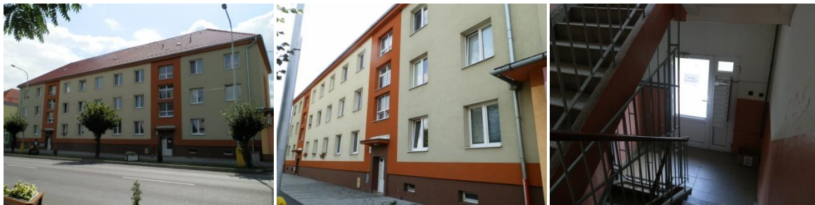
pohľady na bytový dom
